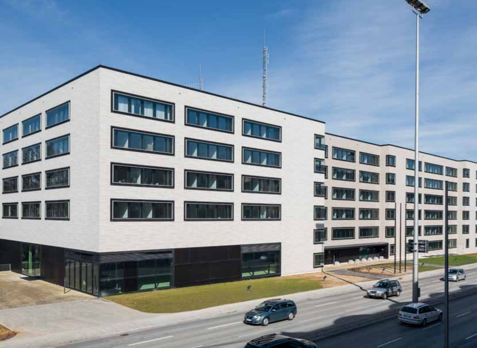
Das Ministeriumsgebäude vom Wullesteg
