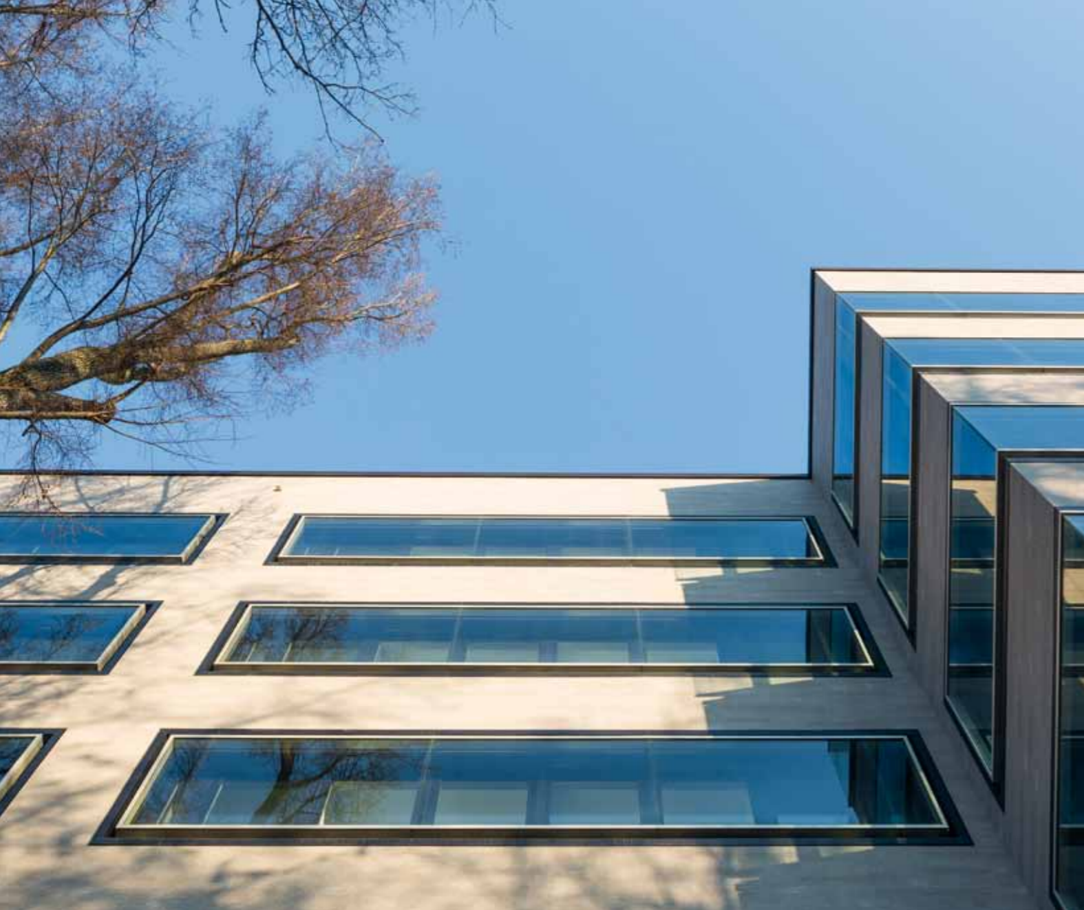
Glasmosaikfassade mit Kastenfenstern
