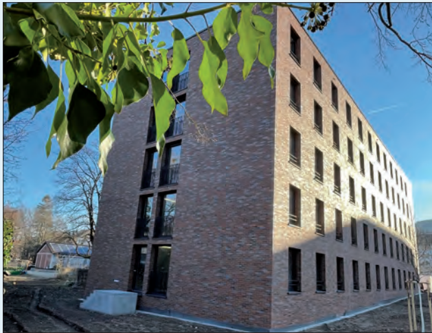
Neubau des Schulgebäudes
