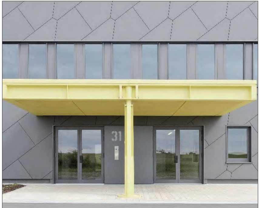
Neubau Halle 01 in Niederstetten – Gebäudehülle wie ein Tarnnetz
