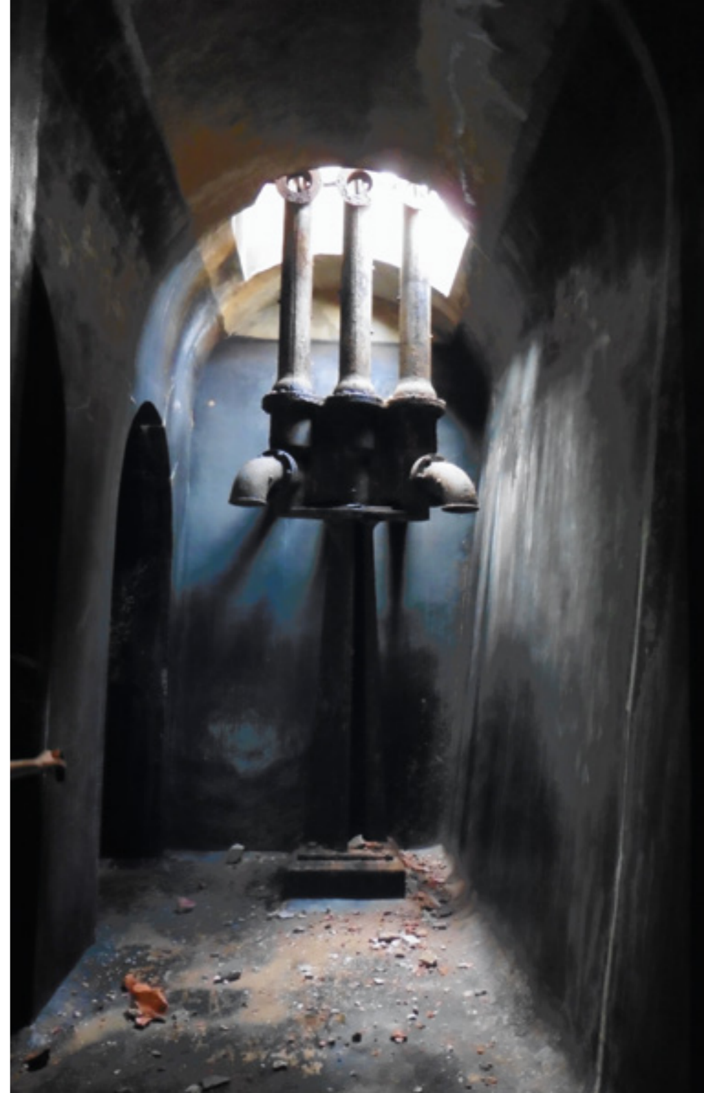
Unterirdisches altes Wasserwerk, Baudenkmal gem. §2 DschG
