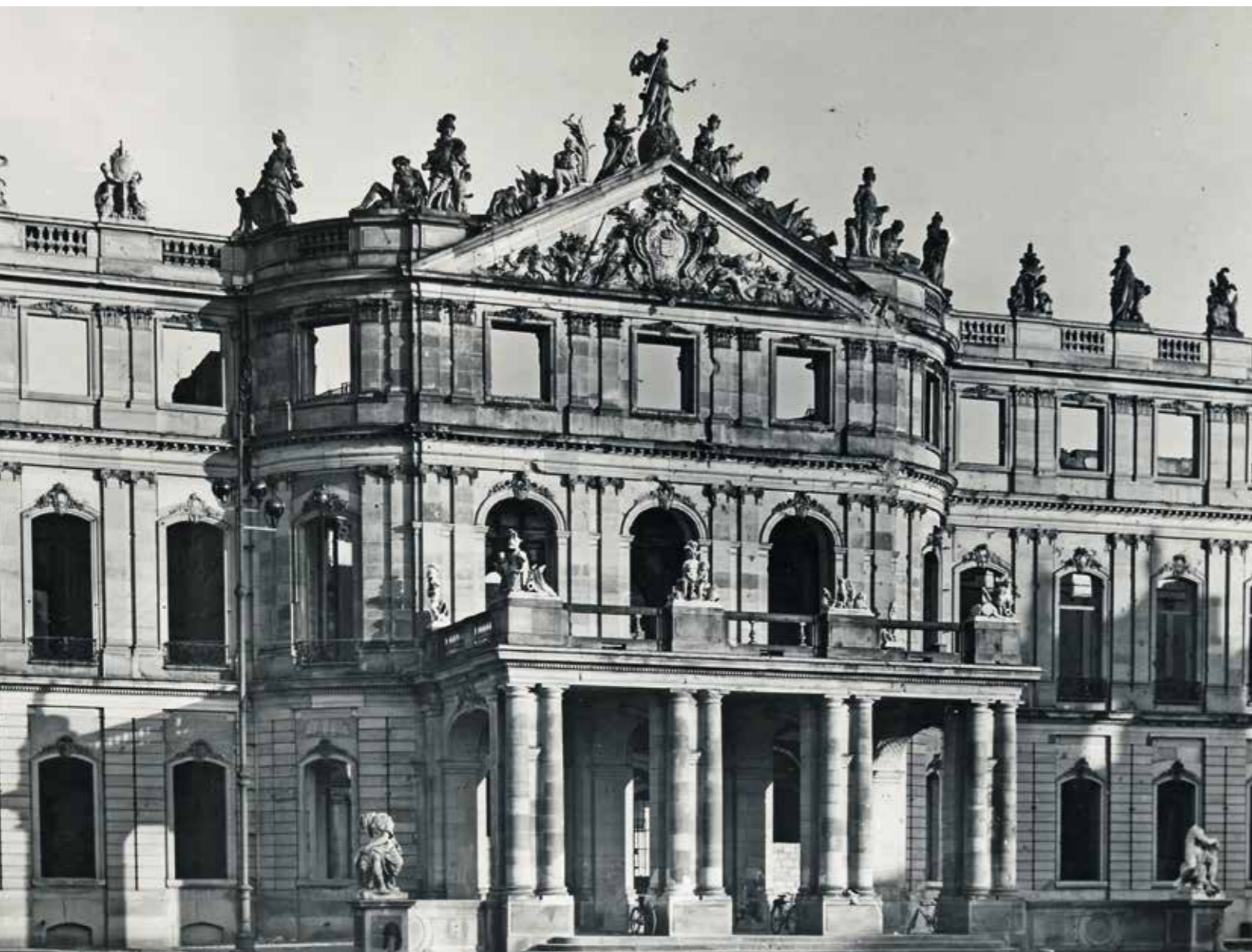
Mittelrisalit des Corps de Logis, 1954
