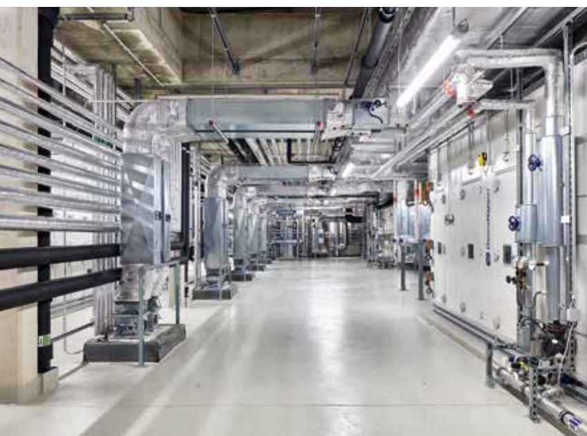
Interdisziplinäres Tumorzentrum des Universitätsklinikums Freiburg: Durch die hocheffiziente Lüftungsanlage des Neubaus können die Räume im Winter durch Abwärme geheizt und im Sommer durch Brunnenwasser gekühlt werden.
