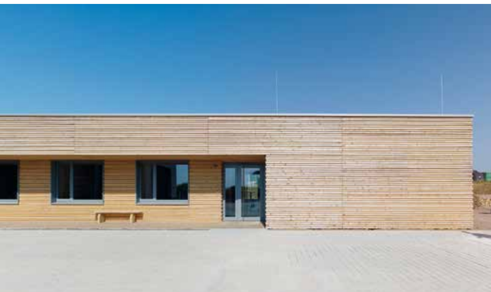
Forststützpunkt Bonndorf: Der Neubau war ein Pilotprojekt für nachhaltiges Bauen und wurde BNB-zertifiziert mit der Auszeichnung »Silber«. Die Wärmeversorgung erfolgt über die benachbarte Holzhackschnittel-Heizung, die Warmwasserbereitung über eine Solarthermie-Anlage.
