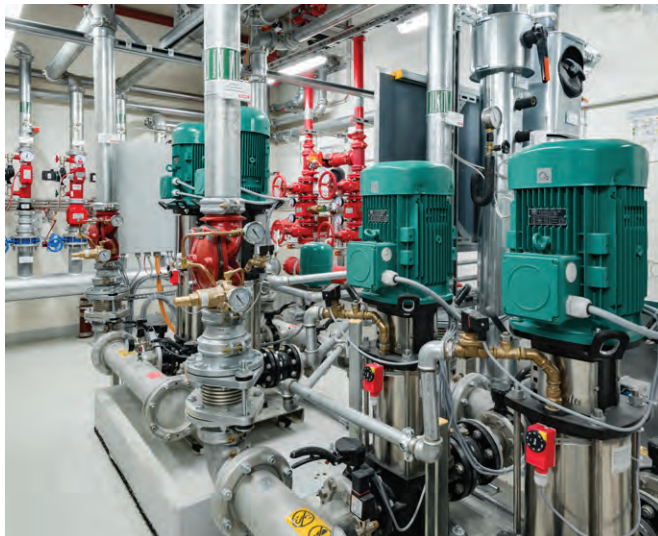
Feuerlöschanlage
