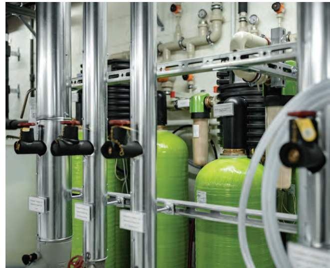
Wasseraufbereitungsanlage Entkalkung
