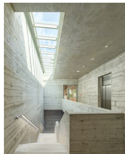
Der Laborneubau in Weinsberg hat als BIM-Pilotprojekt alle wesentlichen Kosten-, Termin- und Qualitätsziele erreicht.
