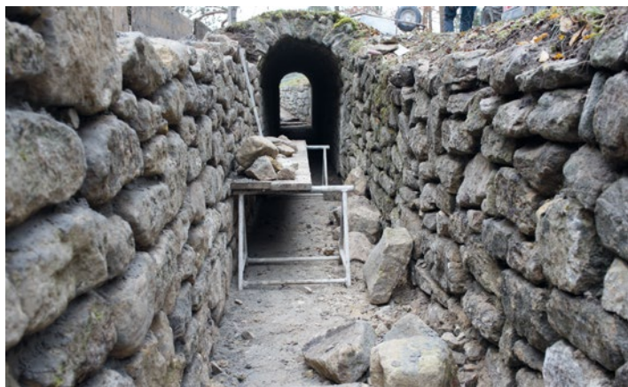
Sanierungsarbeiten am Gewölbemauerwerk.
