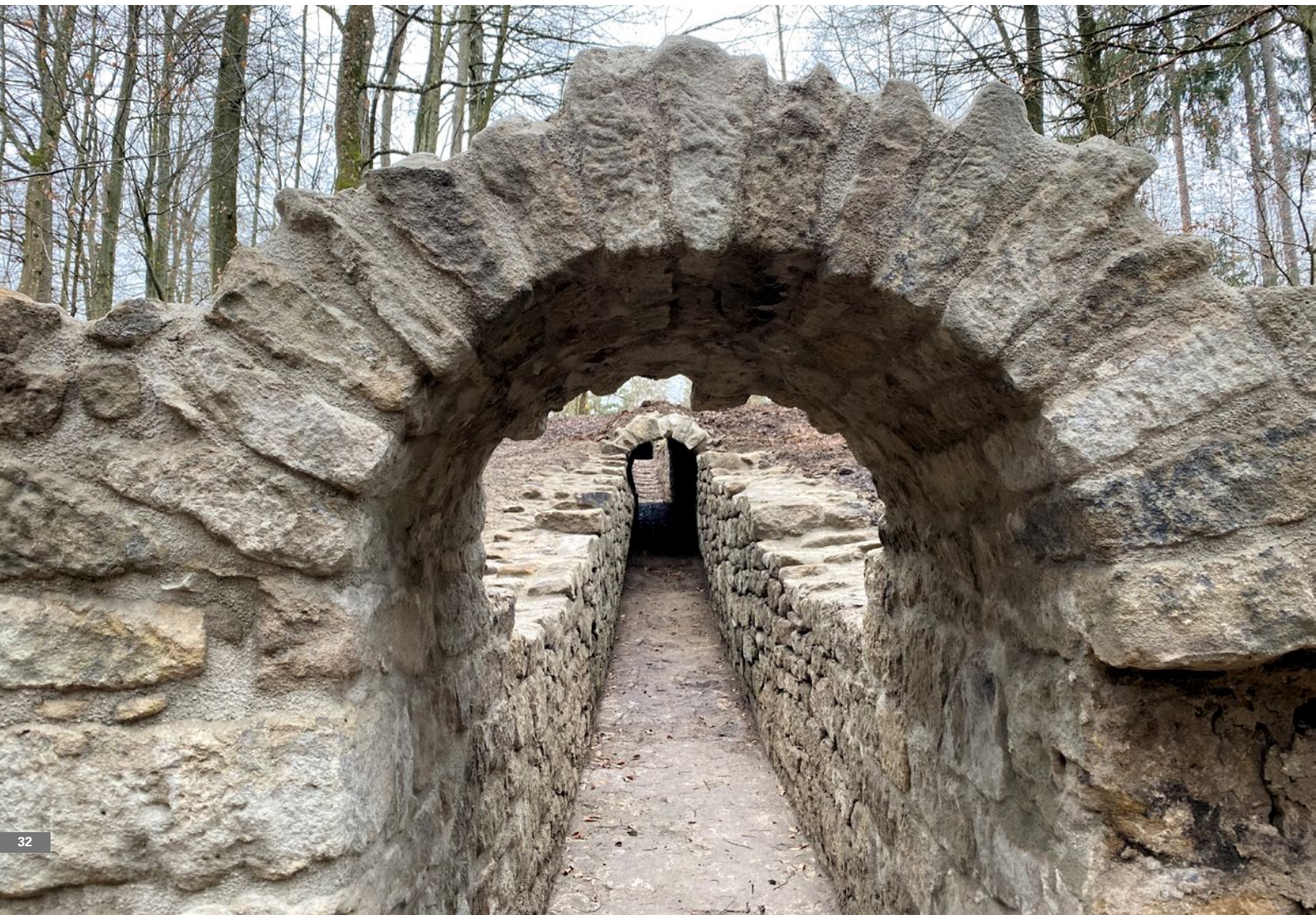
Die sanierte Pirschganganlage im Böblinger Wald.
