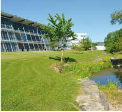
Retentionsfläche mit einem kleinen Bereich mit stehendem Wasser.
