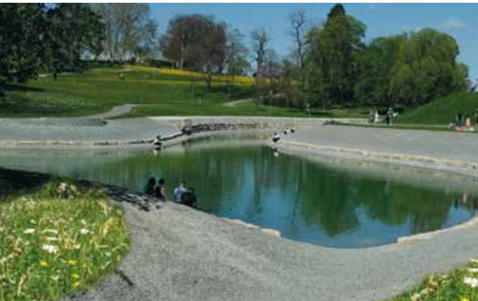
Bei der Sanierung des Insees im Unteren Schlossgarten in Stuttgart stellte sich neben der passenden Abdichtung die Frage, wie „sauber“ der See sein soll und wie viel Energie für dessen Reinigung aufgewendet werden muss.
