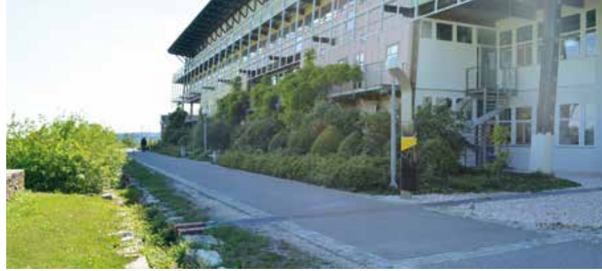
An den Fassaden wachsen Klimmer in die Höhe und verbessern das Kleinklima, in den Rinnen wächst spontane Vegetation bis zum nächsten heftigen Regen.
