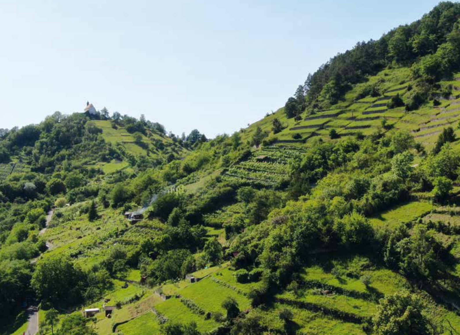
An der Wurmlinger Kapelle (Hirschauer Berg) wurden viele ehemalige Weinbergmauern aufwändig saniert.
