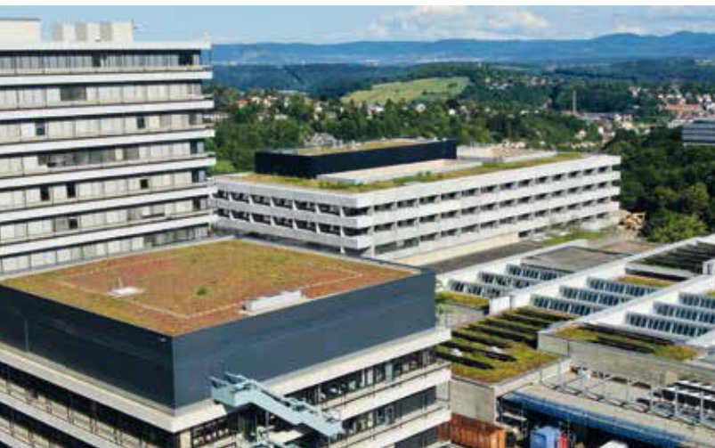
Extensive Dachbegrünung auf Dächern der Universität in Tübingen – zum Teil auch in Kombination mit Photovoltaik-anlagen zur Energiegewinnung.
