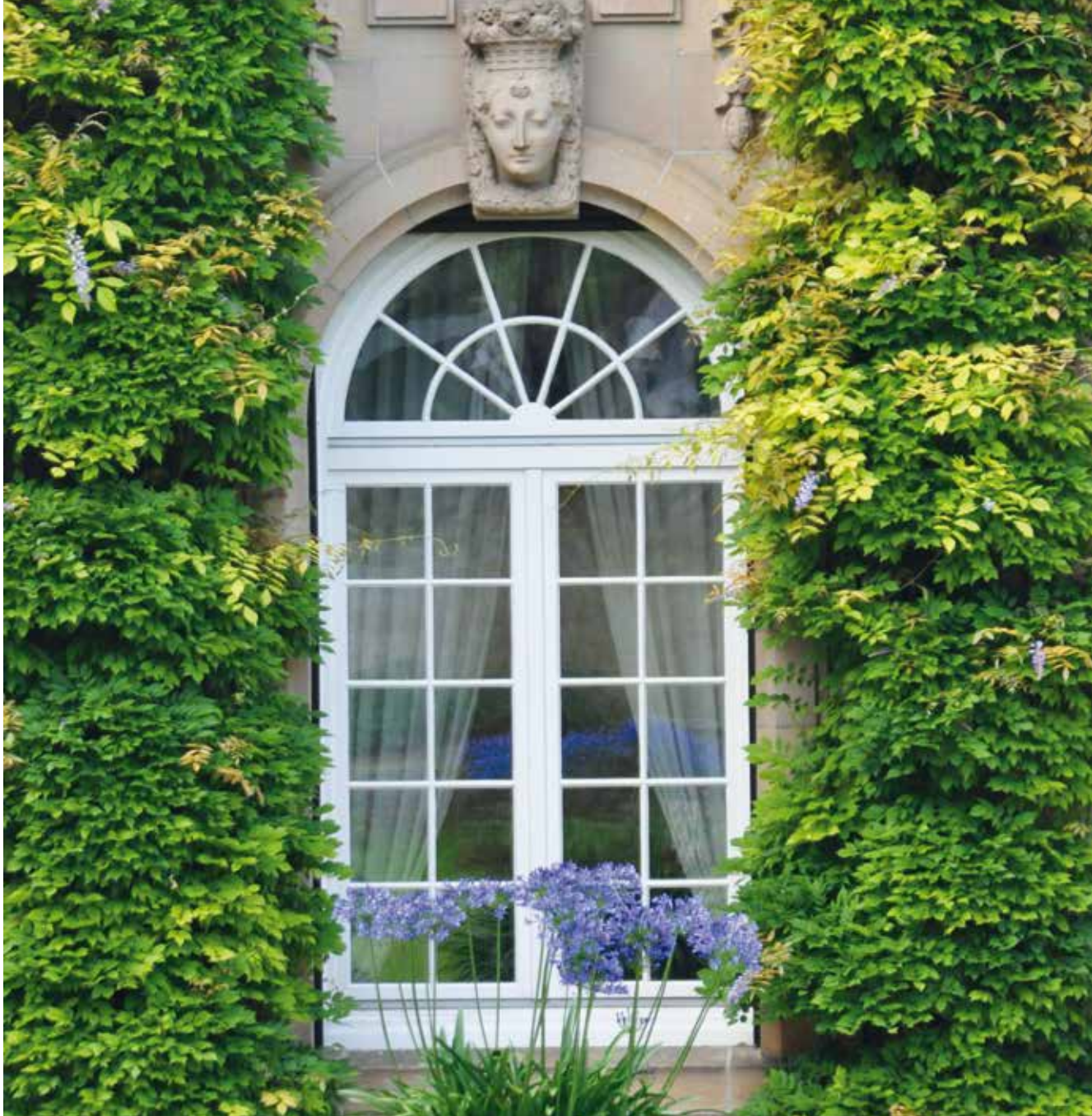
Die Architektur der Villa Reitzenstein in Stuttgart, Sitz des Staatsministeriums Baden-Württemberg, wird durch die geometrische Fassadenbegrünung betont.
