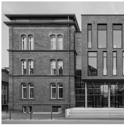
Anschluss Neubau an aufgestockten Altbau
