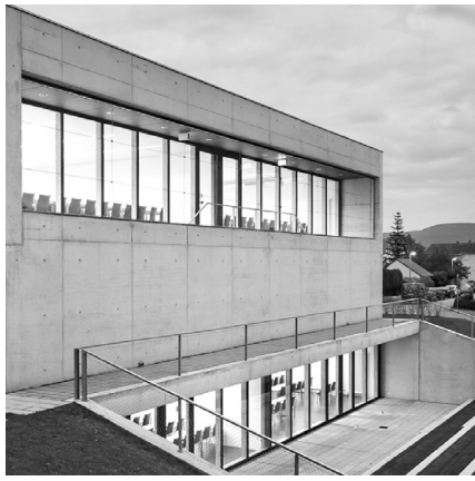
Südansicht mit Hörsälen und Tiefhof
