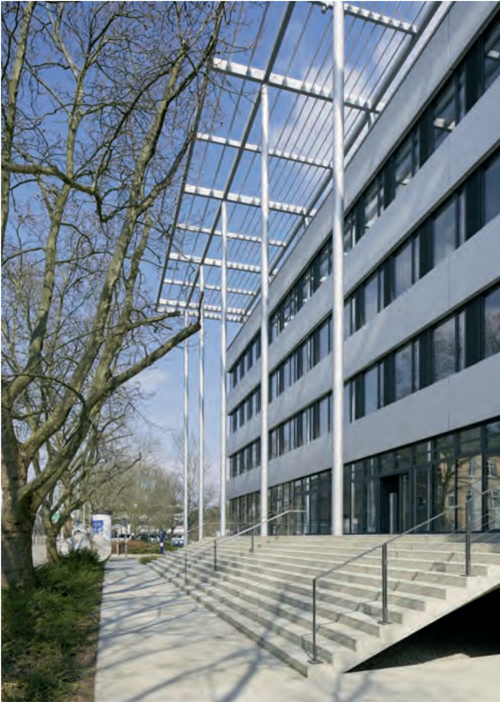
Treppenanlage Fassade Waldhornstraße
