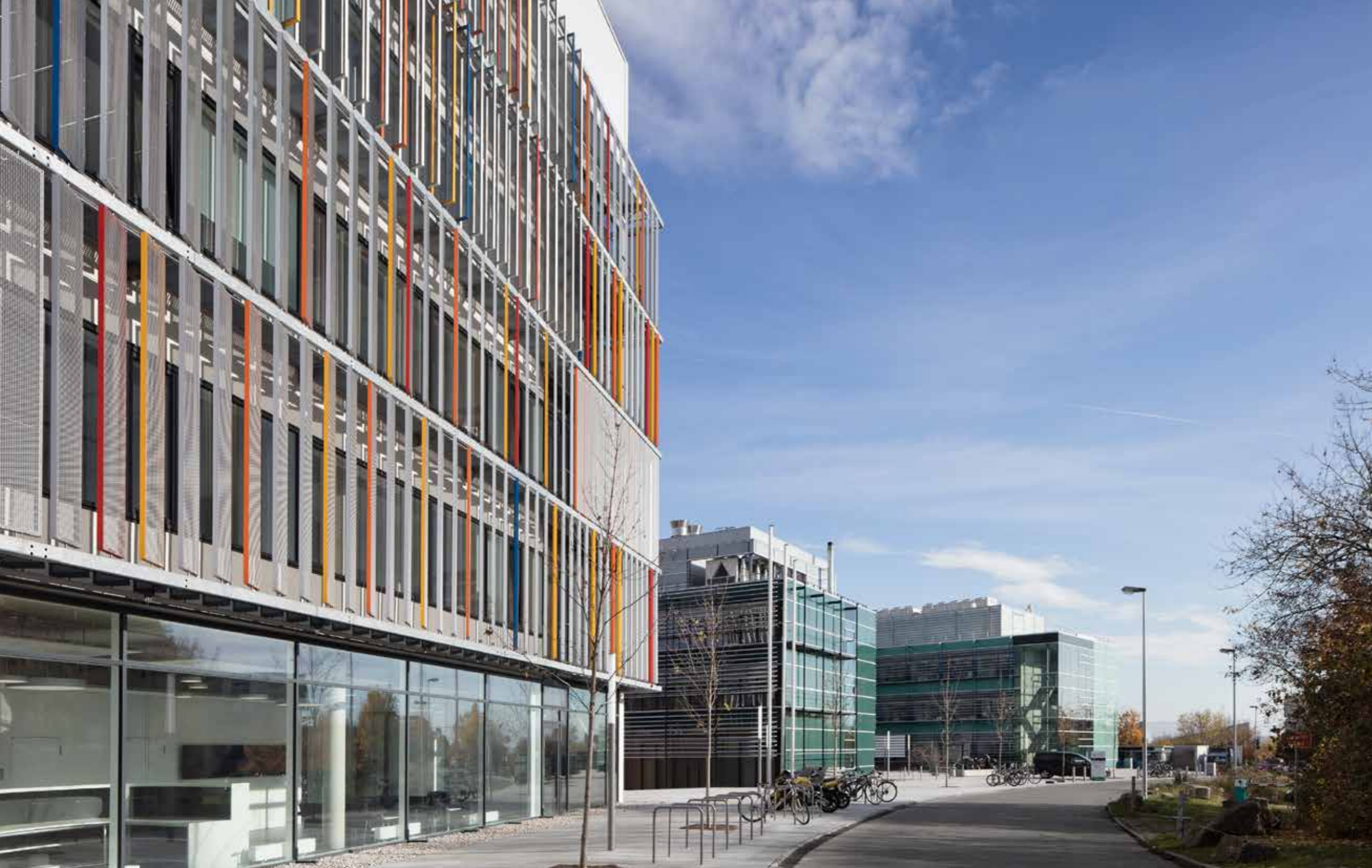
Südwestansicht an der Otfried-Müller-Straße
