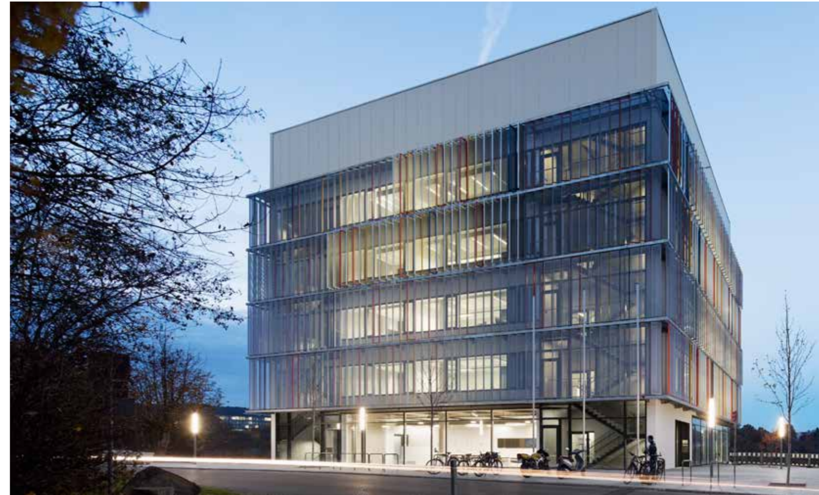
Südwestansicht an der Otfried-Müller-Straße
