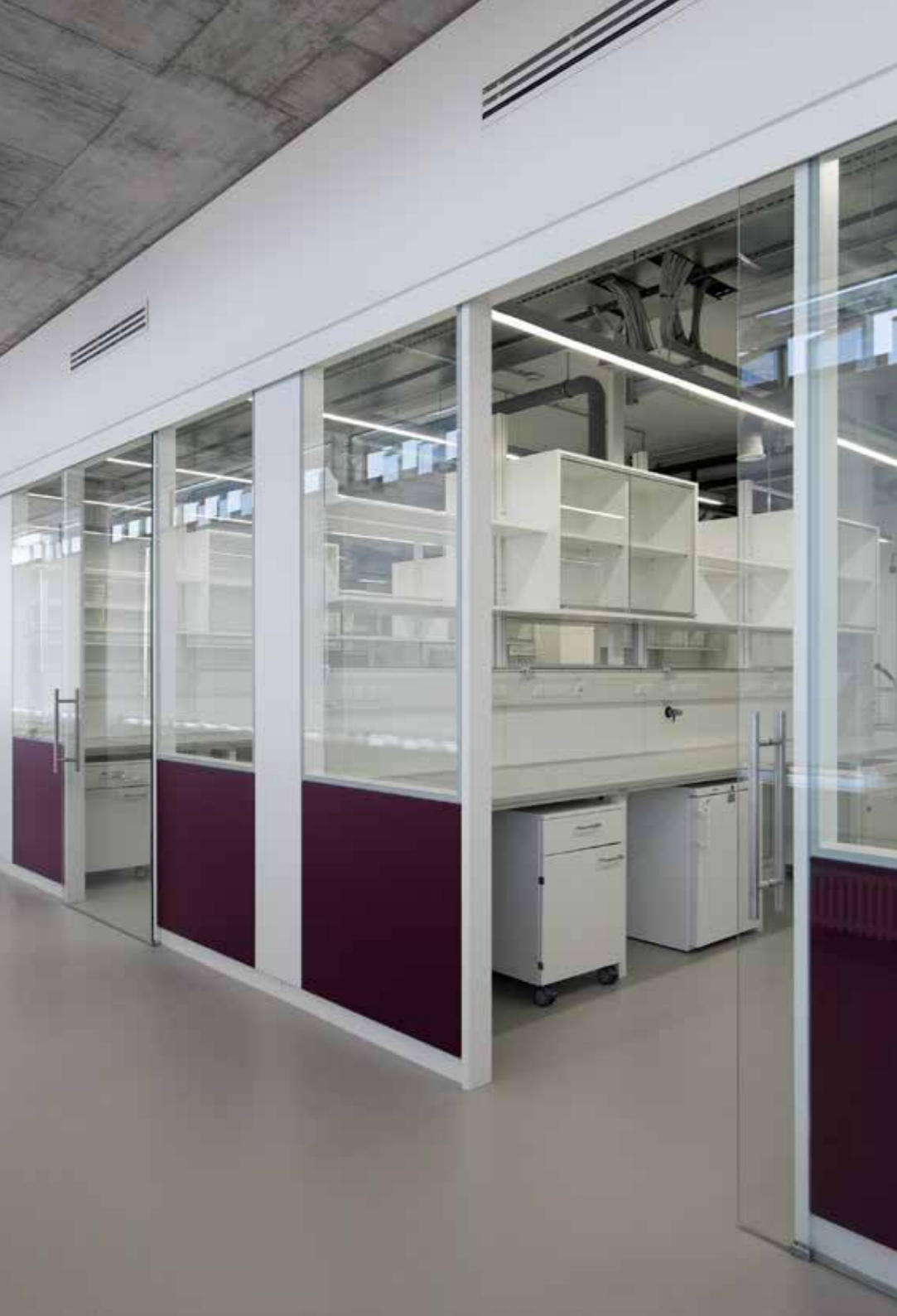
Glastrennwand im Übergang vom Labor zur Dokuzone
